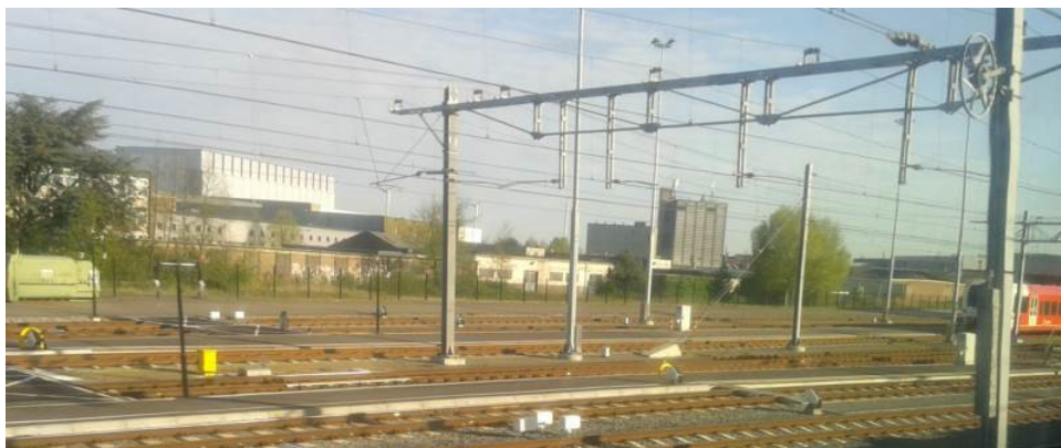
Zicht op de planlocatie en het aangrenzende industrieterrein vanaf het spoor
