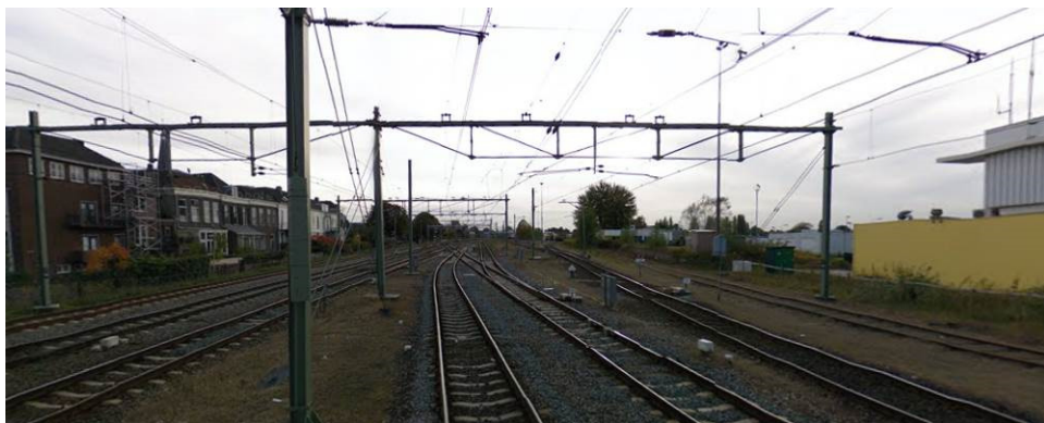
Vanaf overweg in zuidwestelijke richting; links woningen Nieuwstad, rechts de tijdelijke huisvesting van NedTrain en het seinhuis
