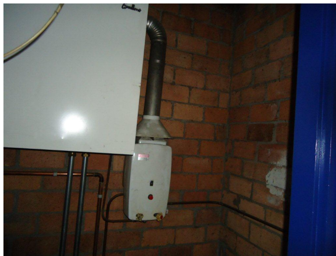
Cv-installatie; niet asbesthoudend.
