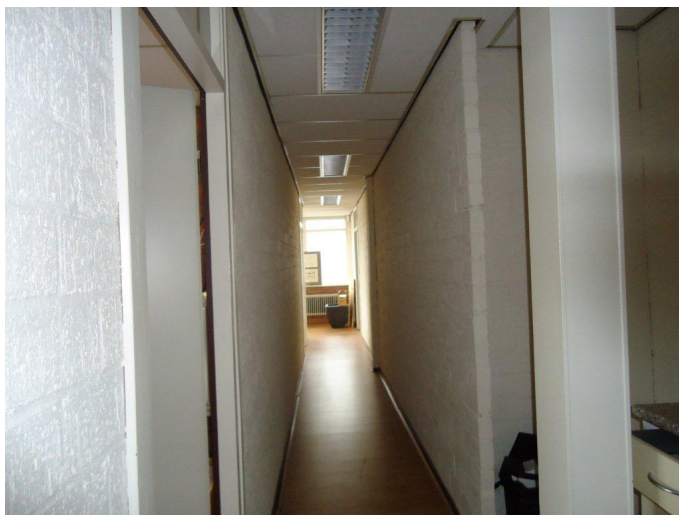
Gang; geen asbesthoudende materialen aangetroffen.
