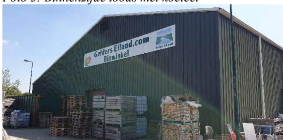
Foto 5: Te verwijderen loods achterzijde
