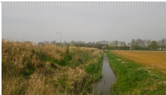
Watergang in het westen van het plangebied
