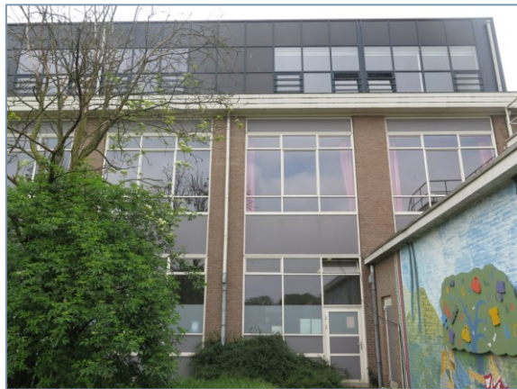
Foto 4. Noordgevel schoolgebouw: paarverblijfplaats.
