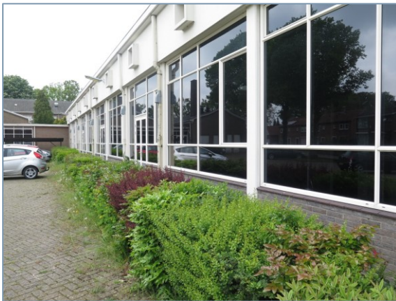
Foto 3. Oostgevel laagbouw (zijde Vestersbos): paar- en zomerverblijfplaats.
