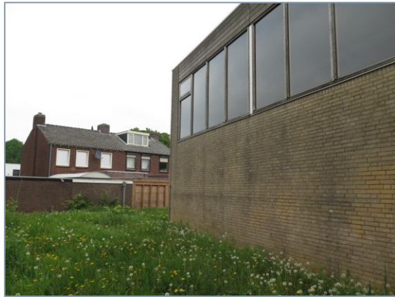
Foto 2. Zuidgevel gymzaal: paarverblijfplaats.
