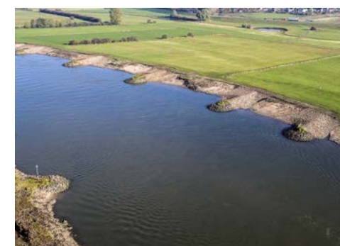
voorbeeld van ontsteende oevers
