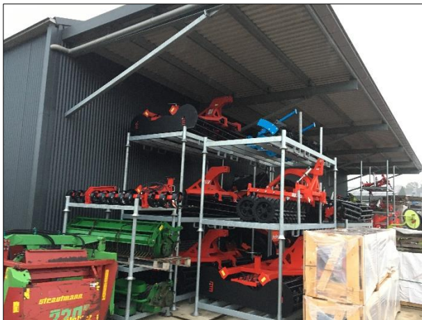
Potentiële nestlocatie van houtduiven onder de overkapping aan de oostzijde van de bedrijfshal.
