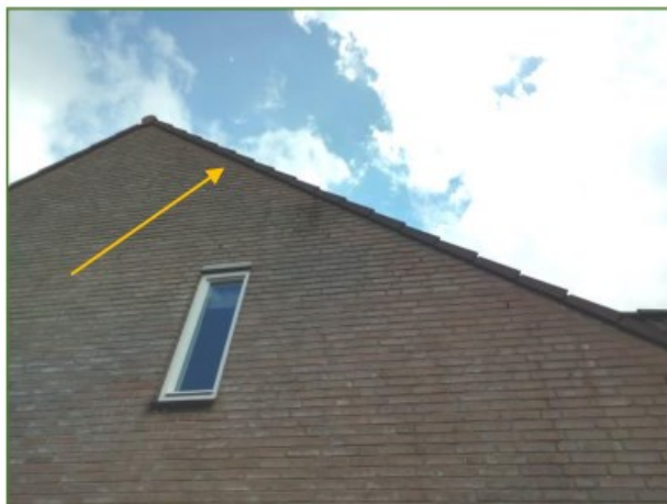
Foto 1: Kopgevel met gevelpannen - zomerverblijf van gewone dwergvleermuis.
