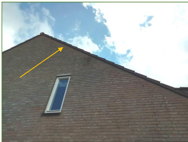
Foto 1: Kopgevel met gevelpannen - zomerverblijf van gewone dwergvleermuis.
