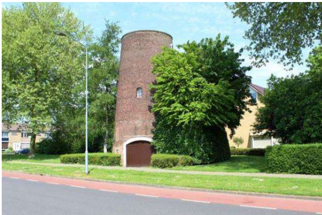
Rechterzijde, gezien vanaf de straat.
