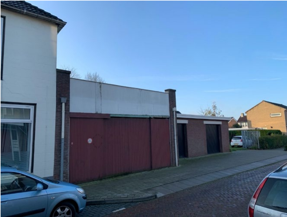
Huidige loods en garageboxen aan de Kotschoollaan 7 en 7g
