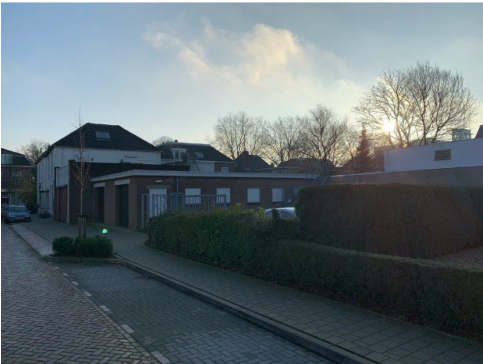
Besluitgebied aan de Kotschoollaan, kijkend tegen de zijgevel van de bestaande garageboxen
