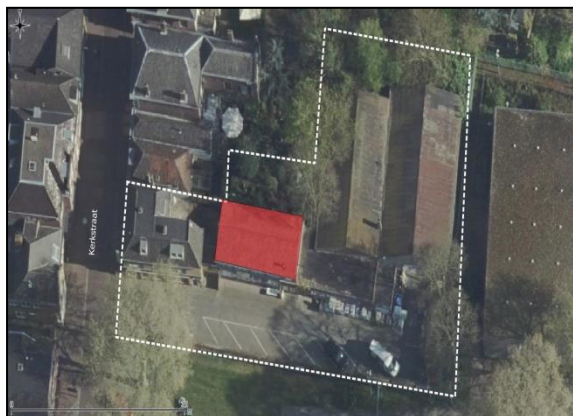
Figuur 9. Ligging van het voor huismussen en gierzwaluw geschikte dak op de onderzoekslocatie.
