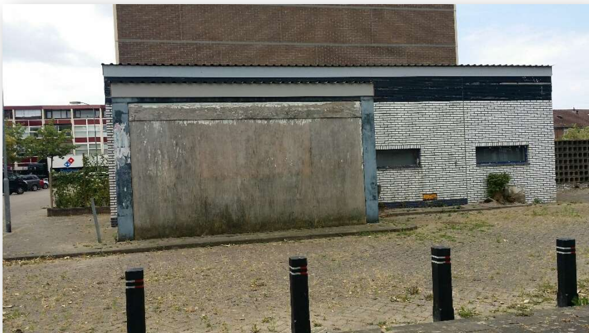
Zicht op het gebouw van het voormalige verkooppunt brandstoffen
