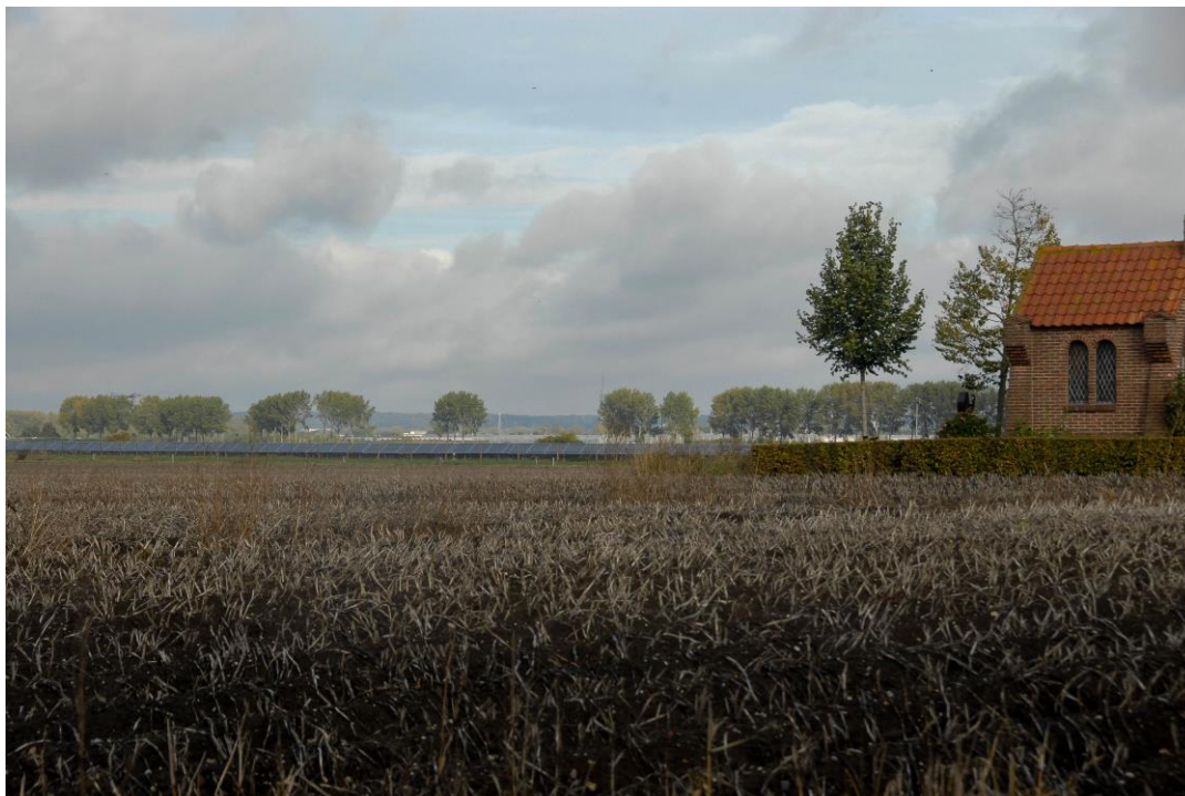
Zonnepark Lingewal Bommel: zicht op zuidzijde opgestelde panelen, het panelenveld vormt een gesloten grijs front. Let wel: nog géén beplanting aangebracht. De lage opstelling van het zonneveld- en groenbeheer gericht op het laaghouden van aan te brengen meidoornhagen, zorgt voor handhaving open landschapsbeeld.
