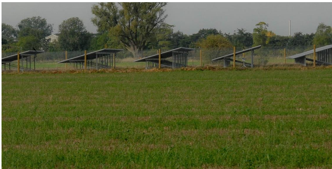
Zijaanzicht panelen in een uitvoering gerealiseerd zonnepark te Bommel: hoogste punt 2,59m. met 1,51 m. tussenruimte in de combinatie met een grofmazig gaashekwerk, 2,00m. hoog.
