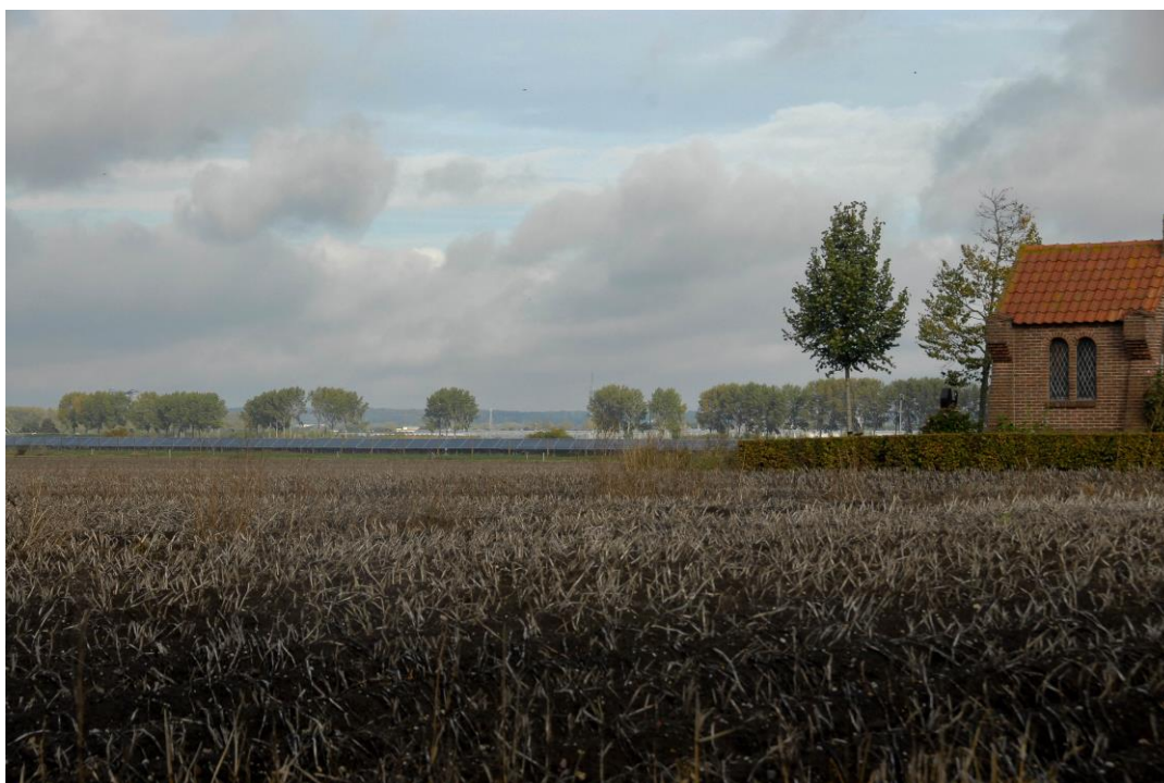
Zonnepark Lingewal Bommel: zicht op zuidzijde opgestelde panelen, het panelenveld vormt een gesloten grijs front. Let wel: nog géén beplanting aangebracht. De lage opstelling van het zonnenveld- en groenbeheer gericht op het laaghouden van aan te brengen meidoornhagen, zorgt voor handhaving open landschapsbeeld.
