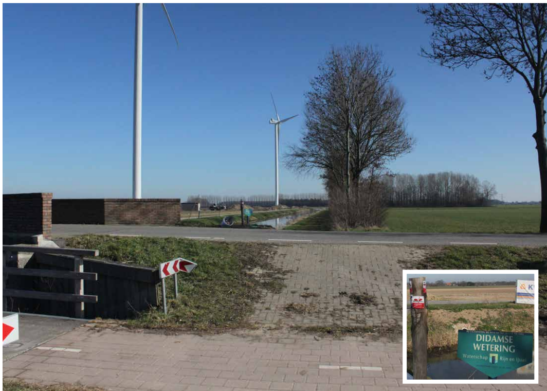
Afbeelding 9. Foto van de brug over de Ganzepoelweg, het klomenpad kruist hier over de weg
