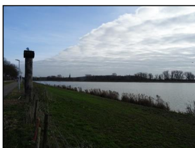
Figuur 7. Waterplas vanaf de noordzijde.
