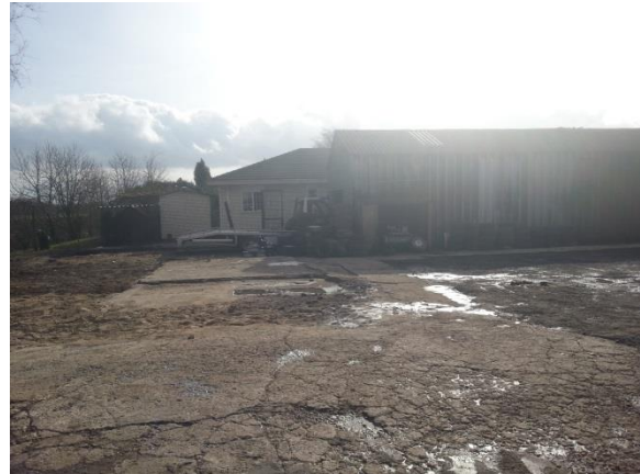
Figuur 9: Overzichtsfoto bebouwing
