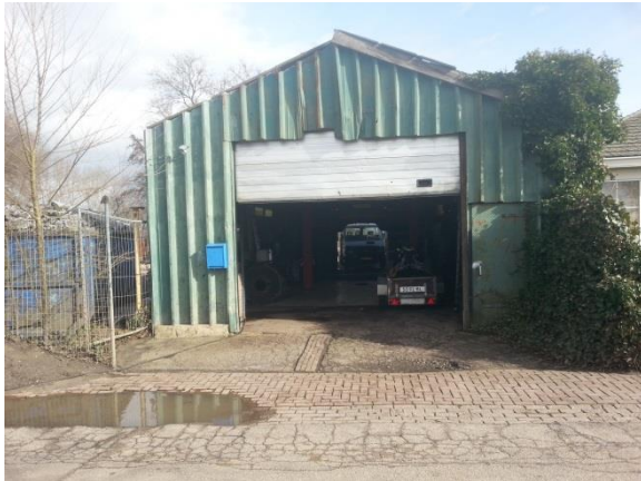
Figuur 8: Overzichtsfoto bebouwing
