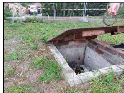
Figuur 9. Put afgesloten door metalen luik.
