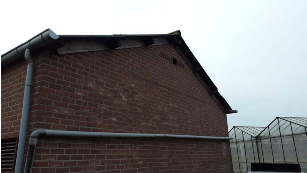
Afbeelding 1: asbestdak met dakgoot
