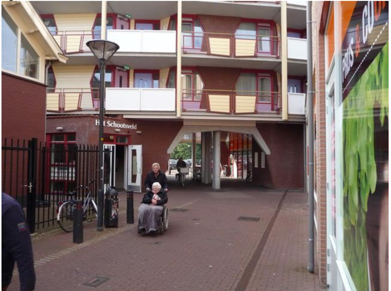
figuur 4: Appartementencomplex 'Het Schootsveld' met links op de foto de (geopende) reguliere voordeur.
