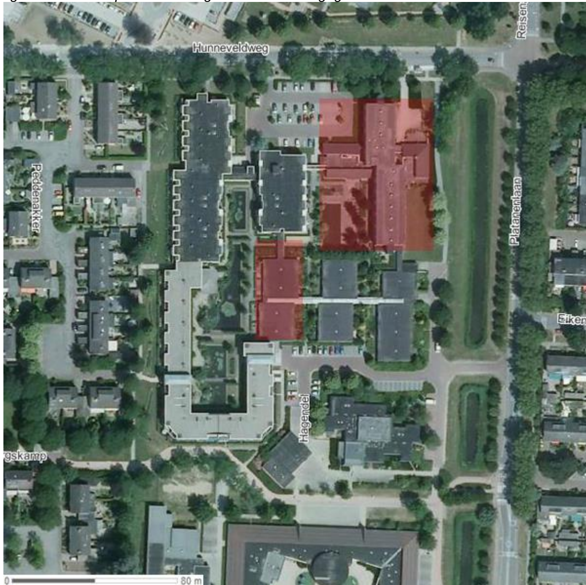
figuur 7: De te slopen bebouwing in het rood weergegeven
