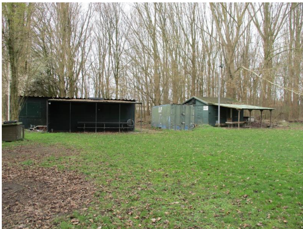
Figuur 2 Het plangebied betreft een hondenschool met verschillende gebouwen.
