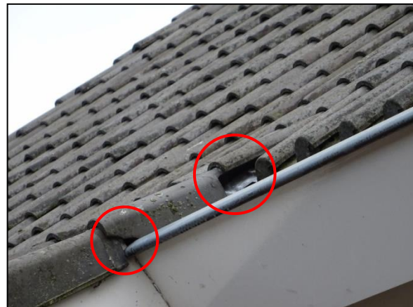
Figuur 12. Toegang voor vleermuizen tot onder de dakpannen.
