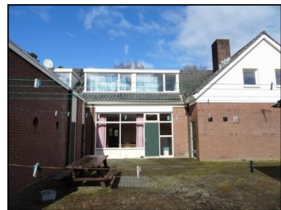
Figuur 5. De zuidzijde van het zalencentrum.
