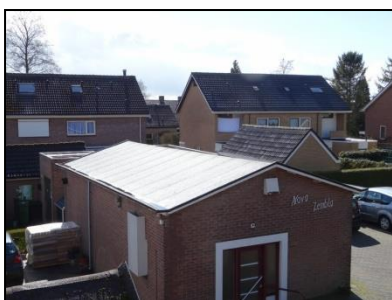
Figuur 6. Bijgebouw 1 gezien vanaf de noordzijde.
