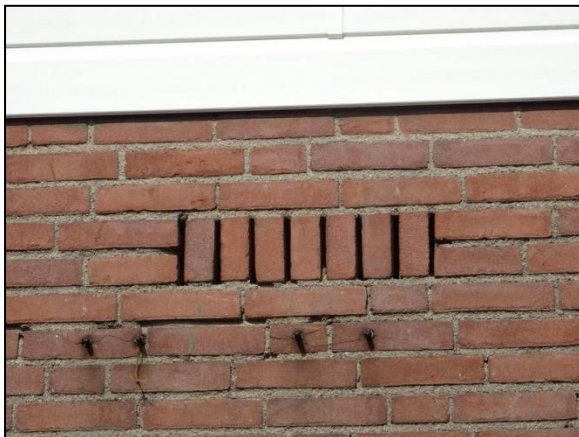
Figuur 11. Toegang voor vleermuizen tot de ruimte van de spouwmuren.
