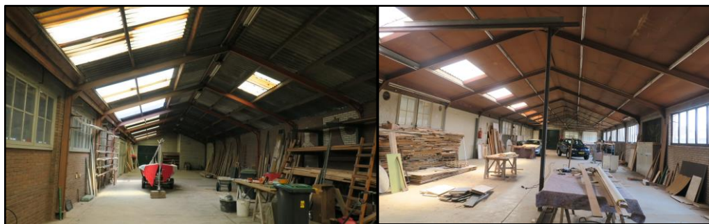
Figuur 6 Dak delen zonder dakbeschot (links) en met dakbeschot (rechts).
