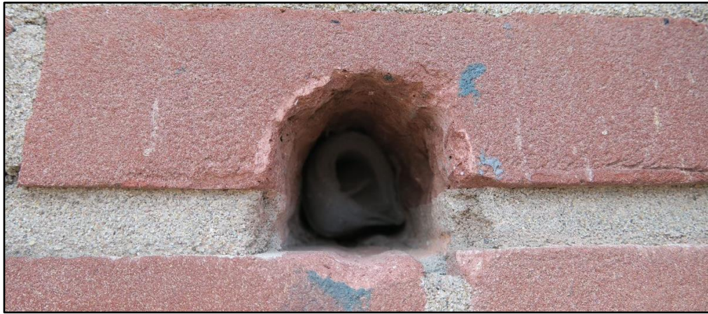
Figuur 5 Aanwezige opening in een spouwmuur.
