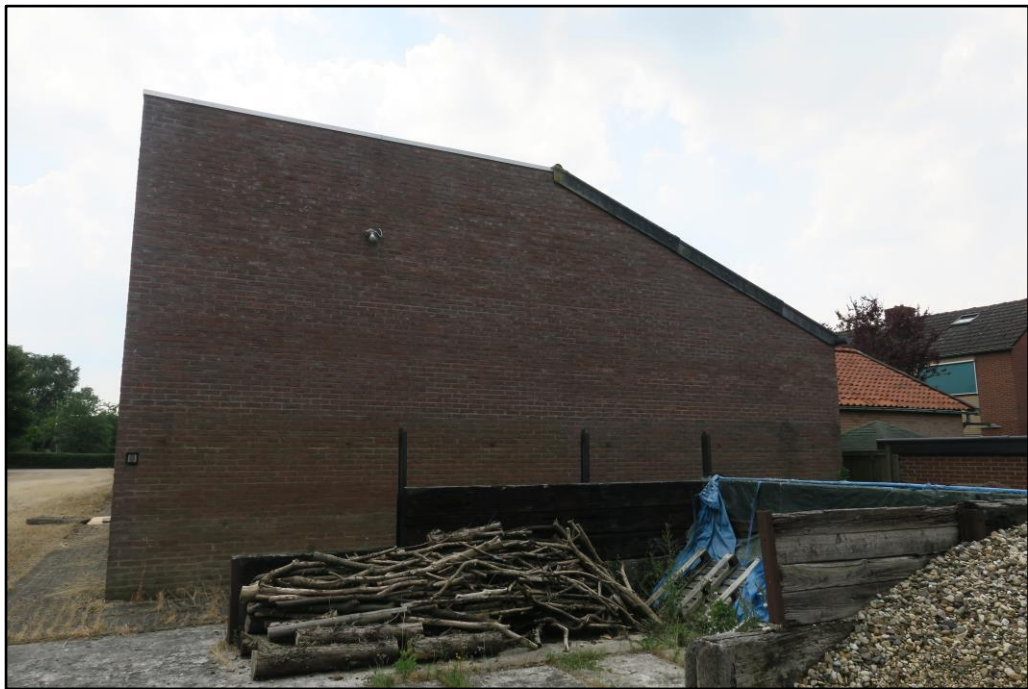
Figuur 4 Het platte dak van bedrijfspand 1.
