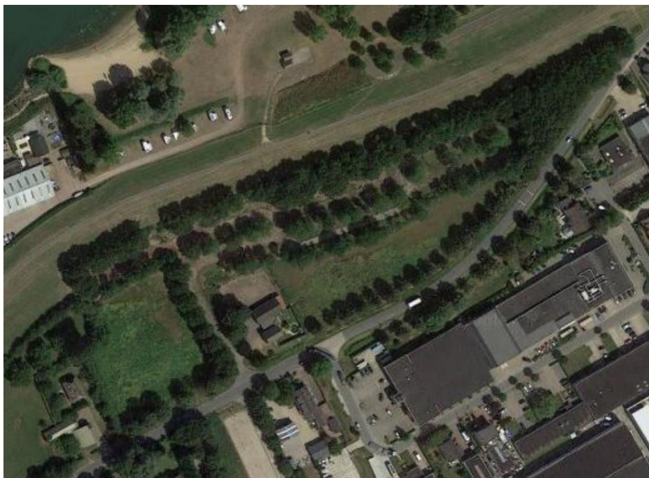
Afbeelding 9: Luchtfoto planlocatie (bron Google Maps). De inrichting komt nog overeen met de inrichting als parkeerterrein. De locatie is nooit daadwerkelijk als kampeerterrein gebruikt.
