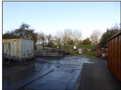
De opslagruimte van het aannemersbdrijf.
