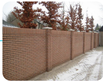
Gemetselde muur met kolommen/poeren en een rollaag
