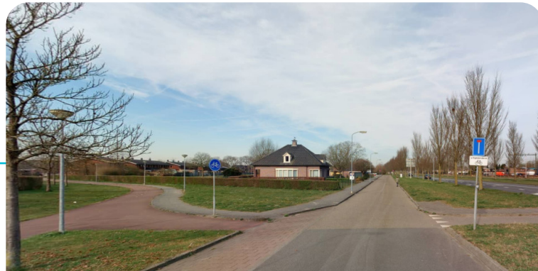
A: Grietakkers : aansluiting fietspad (Veilingpad)
