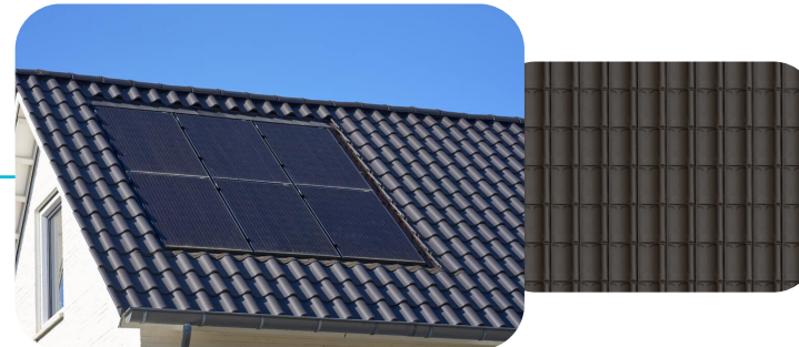
Geïntegreerde zonnepanelen in afstemming met antraciete pannen
