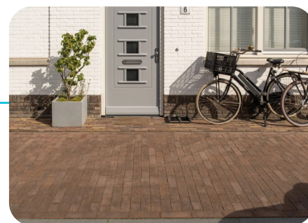
De rijbaan en het trottoir onderscheiden zich in kleurnuance en legverband
