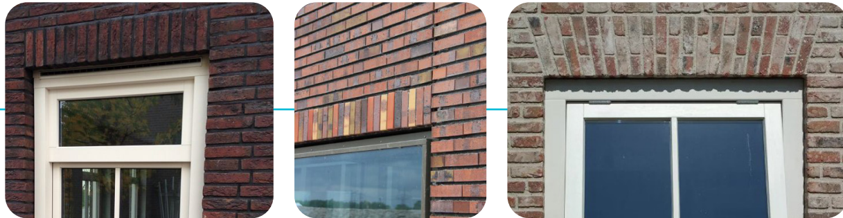
Detaillering in het metselwerk rondom raampartijen en/of luiken voor de ramen
