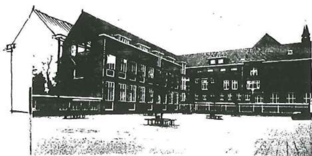
TE VERVANGEN AANBOUW
