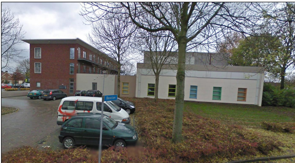
Figuur 19: Opname van het onderzoeksgebied (augustus 2015), met daarop het volledige gebouw van het Muisater en het noordelijk deel van het parkeerterrein. Bron: Google Streetview.
