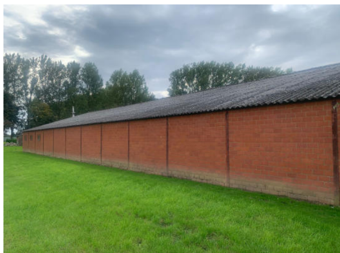
Foto 10 - Druppelzone - schuur met asbestverdachte dakbedekking
