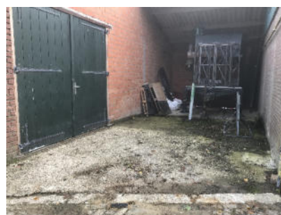
Foto 6 - locatie vml. HBO tank
