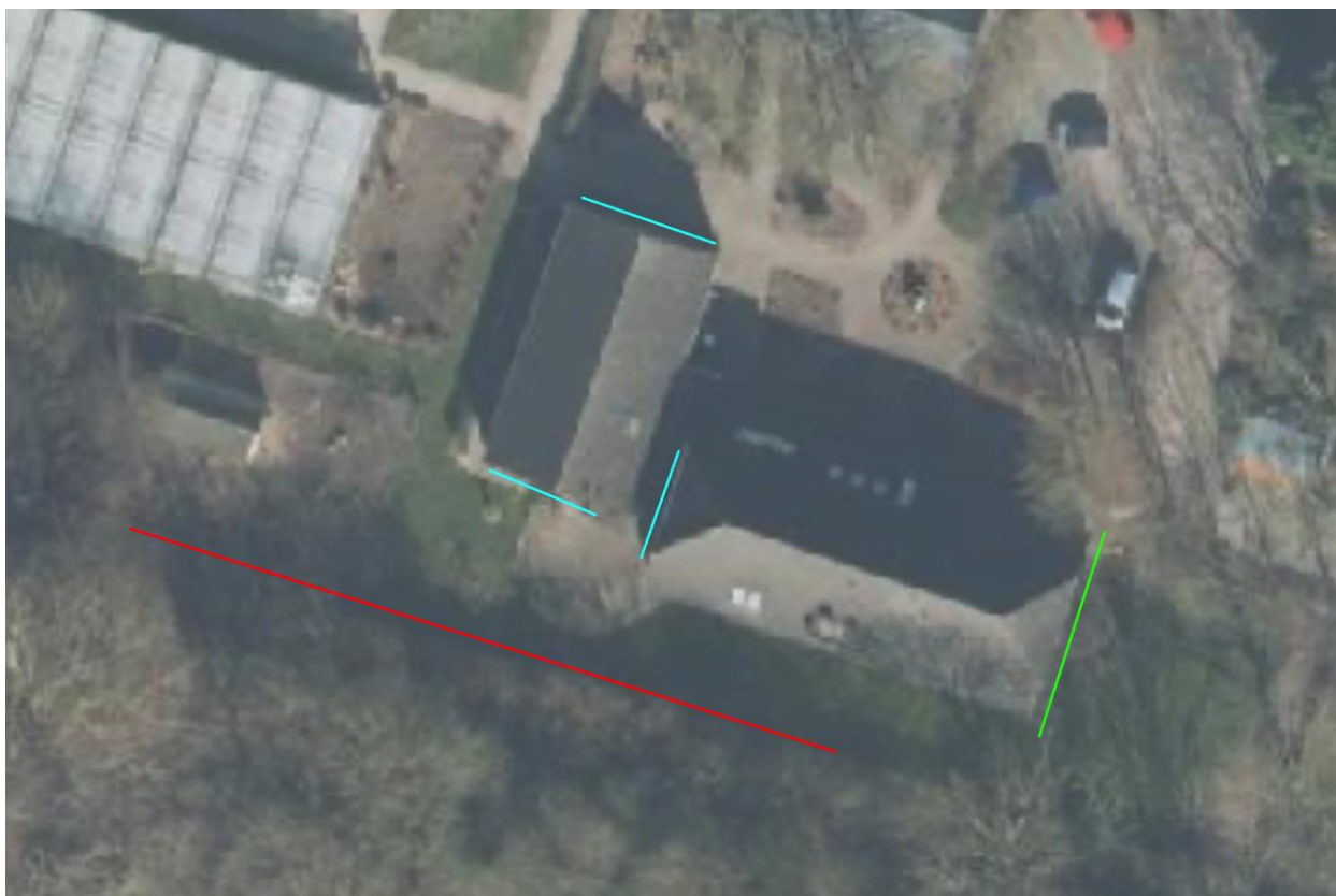
Afbeelding 9: De enige gevel waarin mogelijk verblijven van vleermuizen kunnen zitten ligt aan de Methen (groene lijn). De rode lijn geeft aan waar door meerdere vleermuizen werd gevoerageerd.
