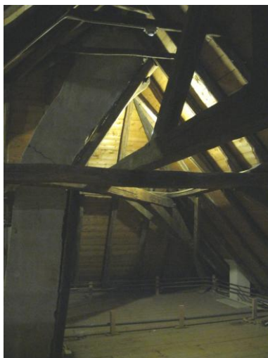
Foto 3: Verlichting op zolder.
