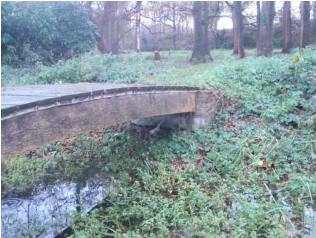
Foto 17: Een van de beide smalle bruggen die leiden vanaf het eiland. De betonnen plaatfundatie is goed zichtbaar.
