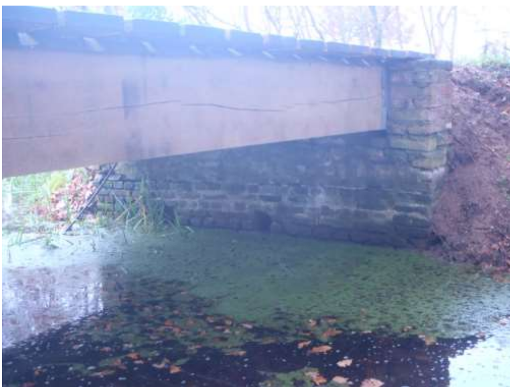
Foto 8; de nieuwe brug naar het eiland met de duiventoren is gebouwd op oud oorspronkelijk metselwerk. Net boven de waterlijn zijn twee uitsparingen zichtbaar van een voormalige steun. Naast de ligger van de brug is het metselwerk aangeheeld.
