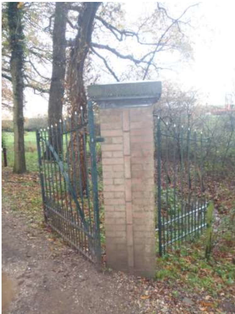
Foto 13: Nieuw opgemetselde kolom van de poort.
