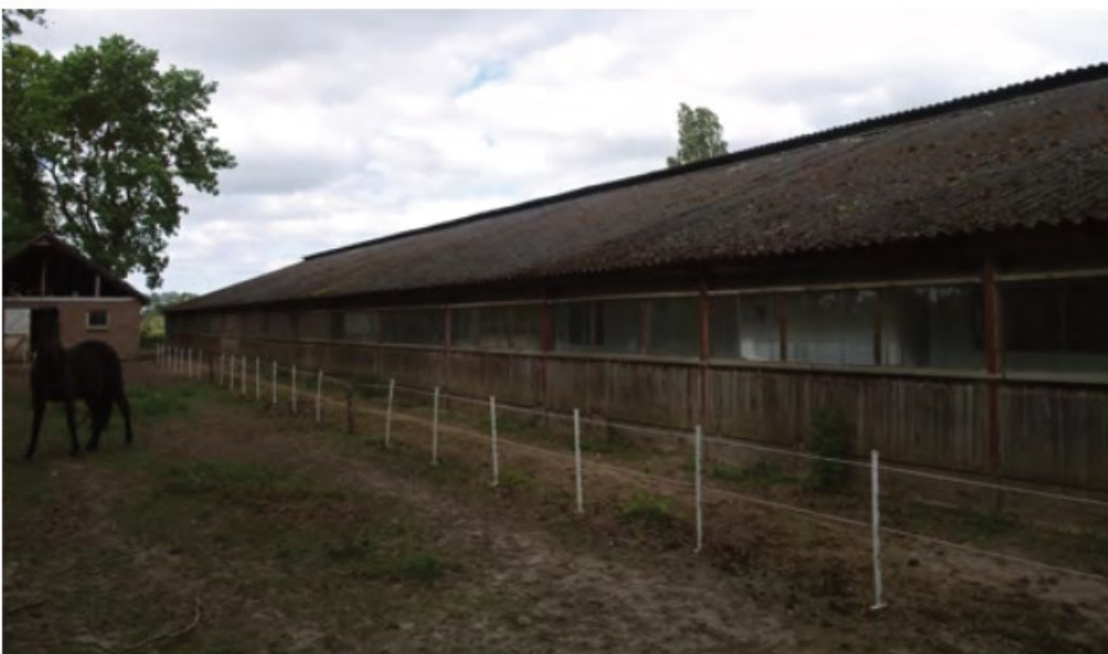
Foto: te slopen schuren
