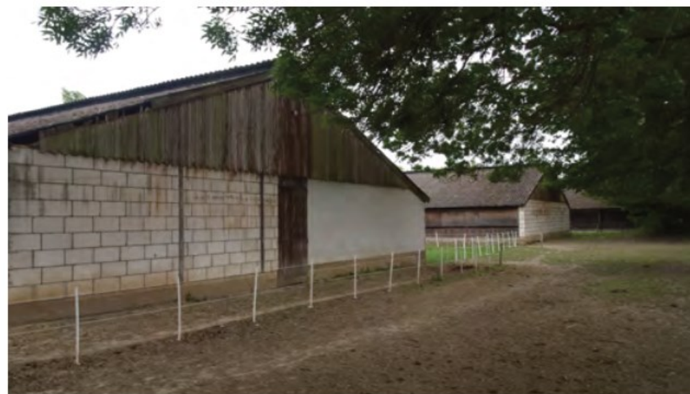
Foto: te slopen schuren
