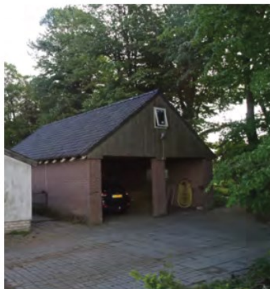
Foto: te behouden carport behorende bij het bestaande woonhuis.
