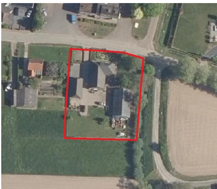
Luchtfoto bestaande situatie plangebied (bron: ruimtelijkeplannen.nl)
