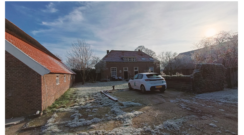
Binnenhof met terras 30x30 tegels, grind en gras Plek van de auto heeft een schuurtje gestaan
