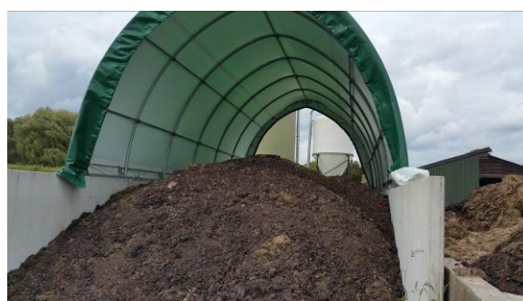
Foto 6: Te verplaatsen mestopslag (bestaande uit betonnen keerwanden, buizenstelsel met zeiloverspanning)
