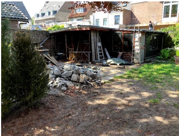
Figuur 3.1 foto huidige situatie
