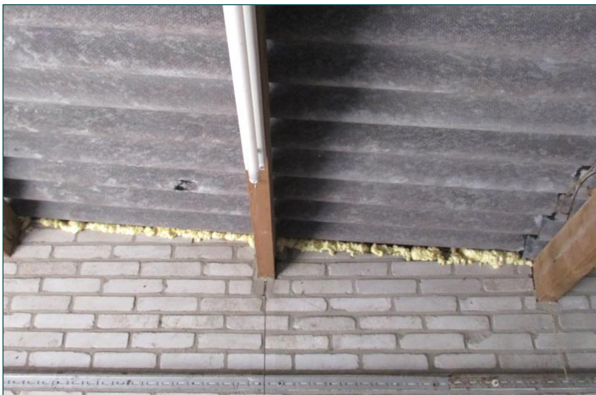
Figuur 3.1 De garageboxen zijn opgebouwd uit enkellaags steense muren, zonder spouw en een golfplatendak zonder dakbeschot. Daarnaast zijn de muren vanuit de binnenzijde dicht gepeurd. Hier kan de aanwezigheid van verblijfplaatsen van vleermuizen uitgesloten worden.
