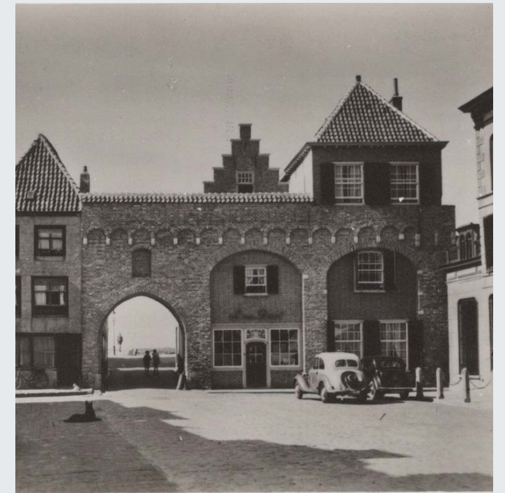
Waterpoort, breed perceel, één gebouw, samengesteld volume, meerdere dakvormen
