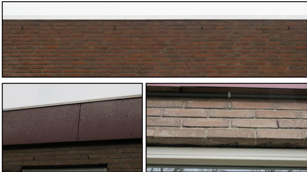
Figuur 1.3 De te saneren bebouwing op de planlocatie is geschikt als potentiële verblijfplaats voor vleermuizen. Geschikte openingen en potentiële verblijfplaatsen voor vleermuizen betreffen: open stootvoegen, kierende trespas beplating en daklijsten, kierende daklijsten en kierende kozijnen.
