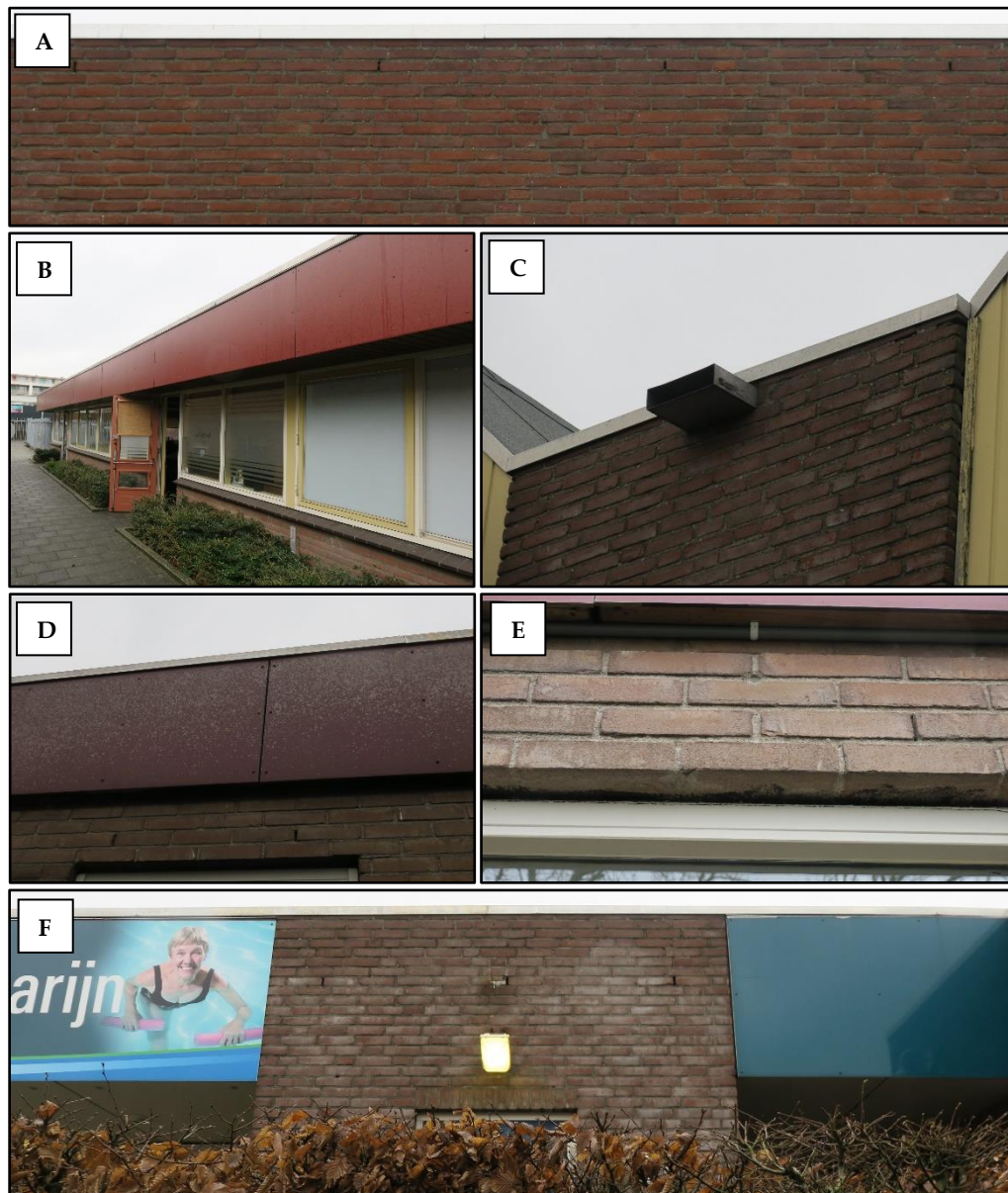
Figuur 3 De te saneren bebouwing op de planlocatie is geschikt als potentiële verblijfplaats voor vleermuizen. Een selectie van de geschikte openingen tot potentiële verblijfplaatsen voor vleermuizen betreffen: A) open stootvoegen in gebouw A; B) kierende trespabeplating en daklijsten van gebouw A; C) kierende daklijst op gebouw A; D) open stootvoegen en kierende trespabeplating van gebouw B; E) kier naast kozijn van gebouw B; F) open stootvoegen in gebouw B.
