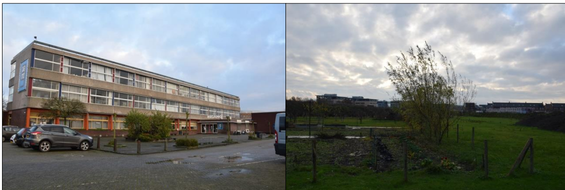
Foto 7 en 8. Links de zuidzijde van het multifunctioneel verzamelgebouw vanuit het zuiden. Rechts de volkstuin ten zuiden van het multifunctioneel verzamelgebouw
