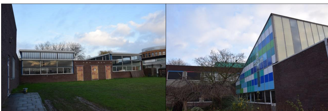
Foto 5 en 6. Links de noordoostzijde van het multifunctioneel verzamelgebouw vanuit het zuiden. Rechts één van de delen van het multifunctioneel verzamelgebouw met kasconstructie
