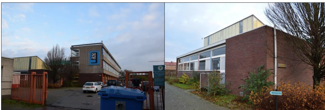
Foto 3 en 4. Links de westgevel van het multifunctioneel verzamelgebouw. Rechts het gebouw van het multifunctioneel verzamelgebouw vanuit het zuidwesten.
