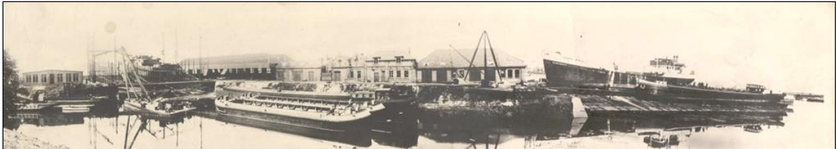
Gezicht op de werf met rechts de reparatiehelling, links het oude kantoorgebouw met daarnaast de beide nieuwbouwhellingen. In het midden de werkplaatsen en magazijnen. Panoramafoto, ca 1930? RAR, bestandnummer SAB 001102106, nummer SAB22-8963.
