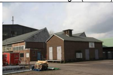
Werkplaats met sheddaken (ca 1935)
