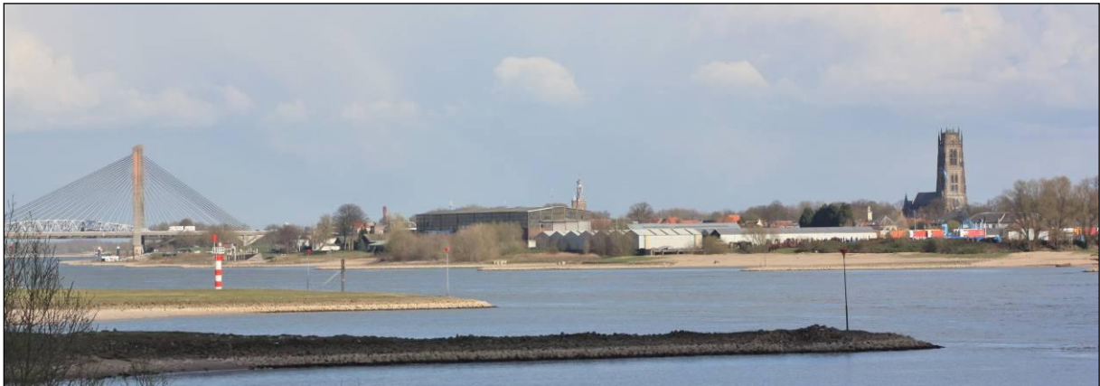
Vanaf de dijk in Haften vormen de grote bedrijfshal, de overige loodsen en de veelkleurige containers in het onderzoeksgebied beeldbepalende elementen.
