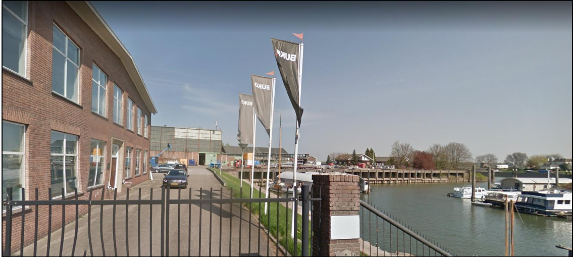
Afbeelding 45: Zicht vanuit de Havendijk op de jachthaven en op de bedrijven in het onderzoeksgebied "Buitenstad Zaltbommel". De walmuur met daarop de kraansteiger uit 1952 is nog aanwezig. (Google Maps, april 2019)
