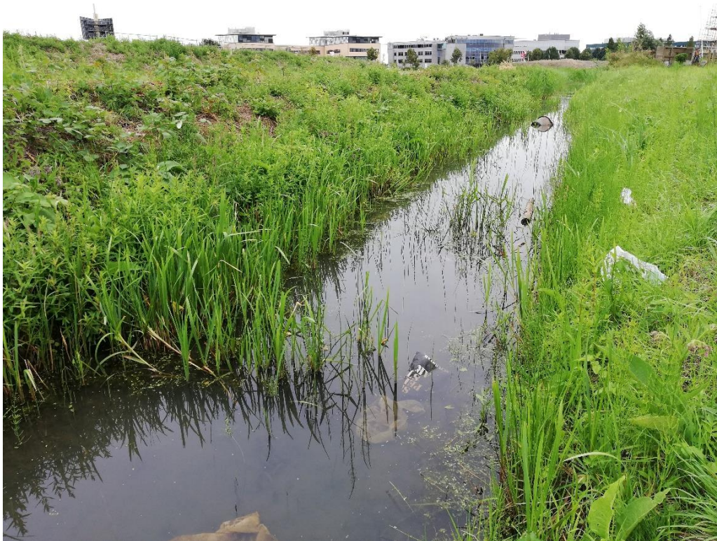
Figuur 4 Te dempen sloot binnen het plangebied.
