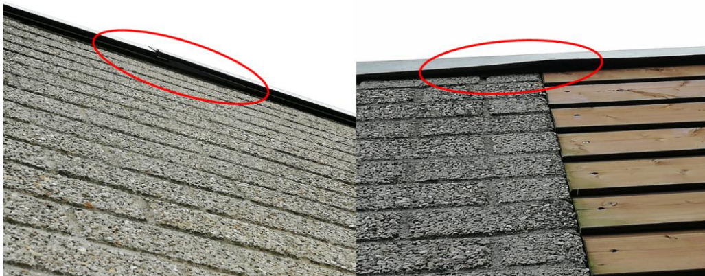
Figuur 2 Kierende daklijsten in de bebouwing geven toegang tot de spouw. Derhalve kan de aanwezigheid van verblijfplaatsen van vleermuizen niet op voorhand worden uitgesloten en dient er aanvullend onderzoek uitgevoerd te worden.
