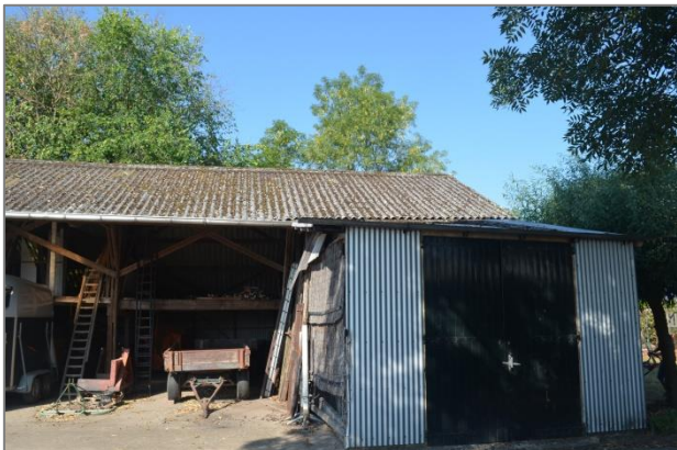
Afbeelding 2.7 | De open kapschuur met een aanbouw.
