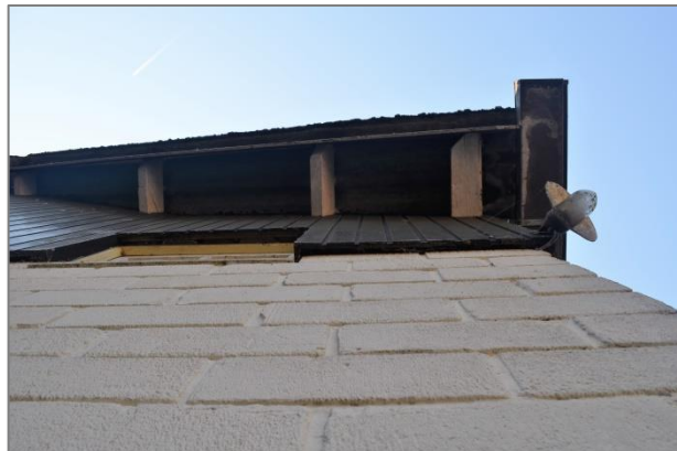
Figuur 5.1 | De potentiële verblijfplaats achter de betimmering.
