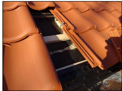
Figuur 25. Voorbeeld plaatsen vogelschroot bij derde rij dakpannen.
