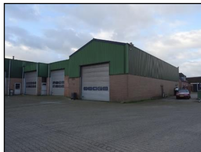
Figuur 7. Overzicht van loodsen (gebouw 7) op het industrieterrein.
