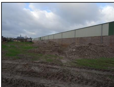
Figuur 9. Zuidzijde van gebouw 7.
