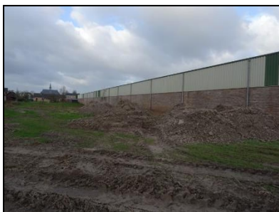
Figuur 9. Zuidzijde van gebouw 7.
