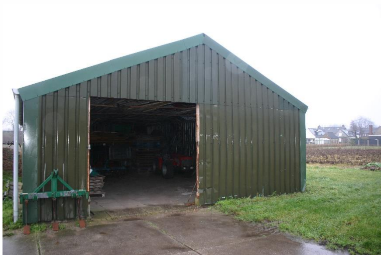
Figuur 4.1.4. De westelijk gelegen schuur is uit damwand opgetrokken.
